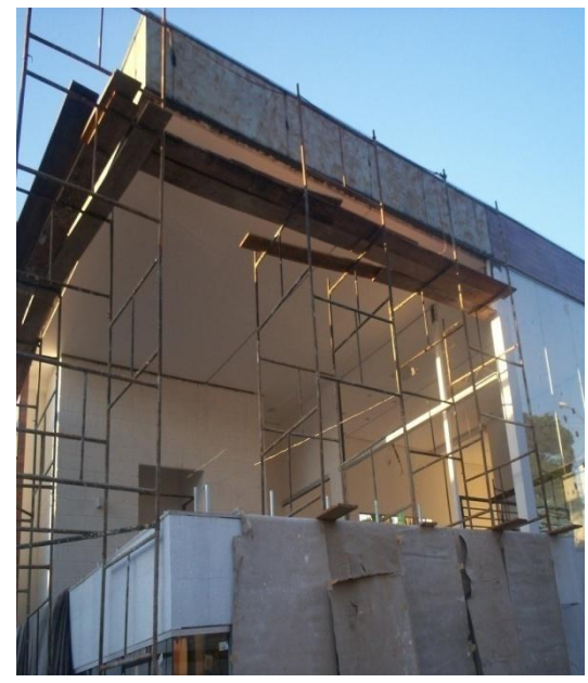
Foto da fachada com o produto aplicado como ponte de aderência
