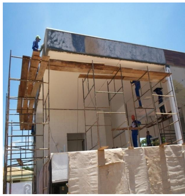
Foto da fachada com o produto aplicado como ponte de aderência
