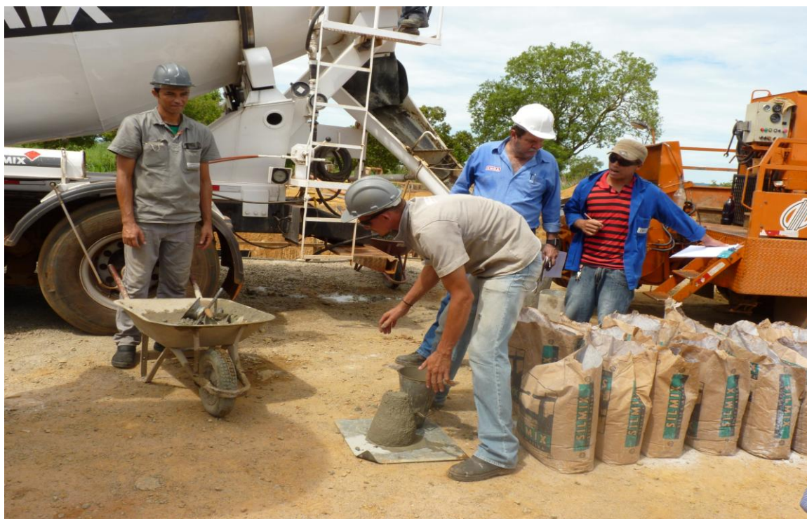
Verificação e controle de Slump sem adição de aditivo MSET POLI 4.
